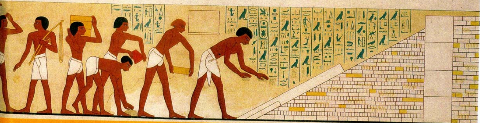
▲ Construction d'un temple. Égypte, peinture Nouvel Empire, 18 e dynastie ; tombe de Rekhmara.
